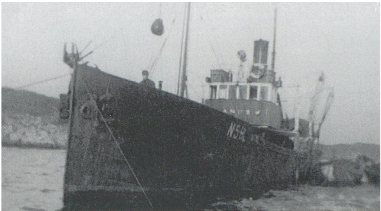
B.Nr:26. ANDØ. Fiskebåt til Hindø Dampskipsselskap i Bodø. Kontrahert i Juli 1904 og overlevert 27. Januar 1905. Lengden var 24,7 meter, bredden var 5,5 meter og 80 bruttotonn. Dampmotoren, en compound på 125 ihk og kjel er fra M+K. I 1910 ble den forlenget til 28,9 meter. Ny bruttotonn på 99. I 1937 ble den solgt til J. M. Johansen i Stamsund. 4. Mars 1941 ble den skutt i senk av britiske jagerfly i "Lofotenraidet", utenfor Lofoten på vei fra Stamsund med oljefat . Alle berget.
